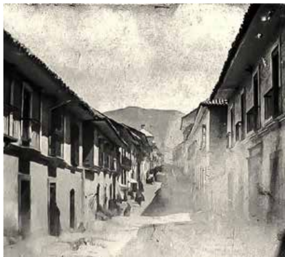
Foto 4: Calle Mercado esquina Loayza (1895). La primera casa de la derecha corresponde al Hospital de Mujeres Loayza, donde funcionaba la botica. Autor: Biggemann.
